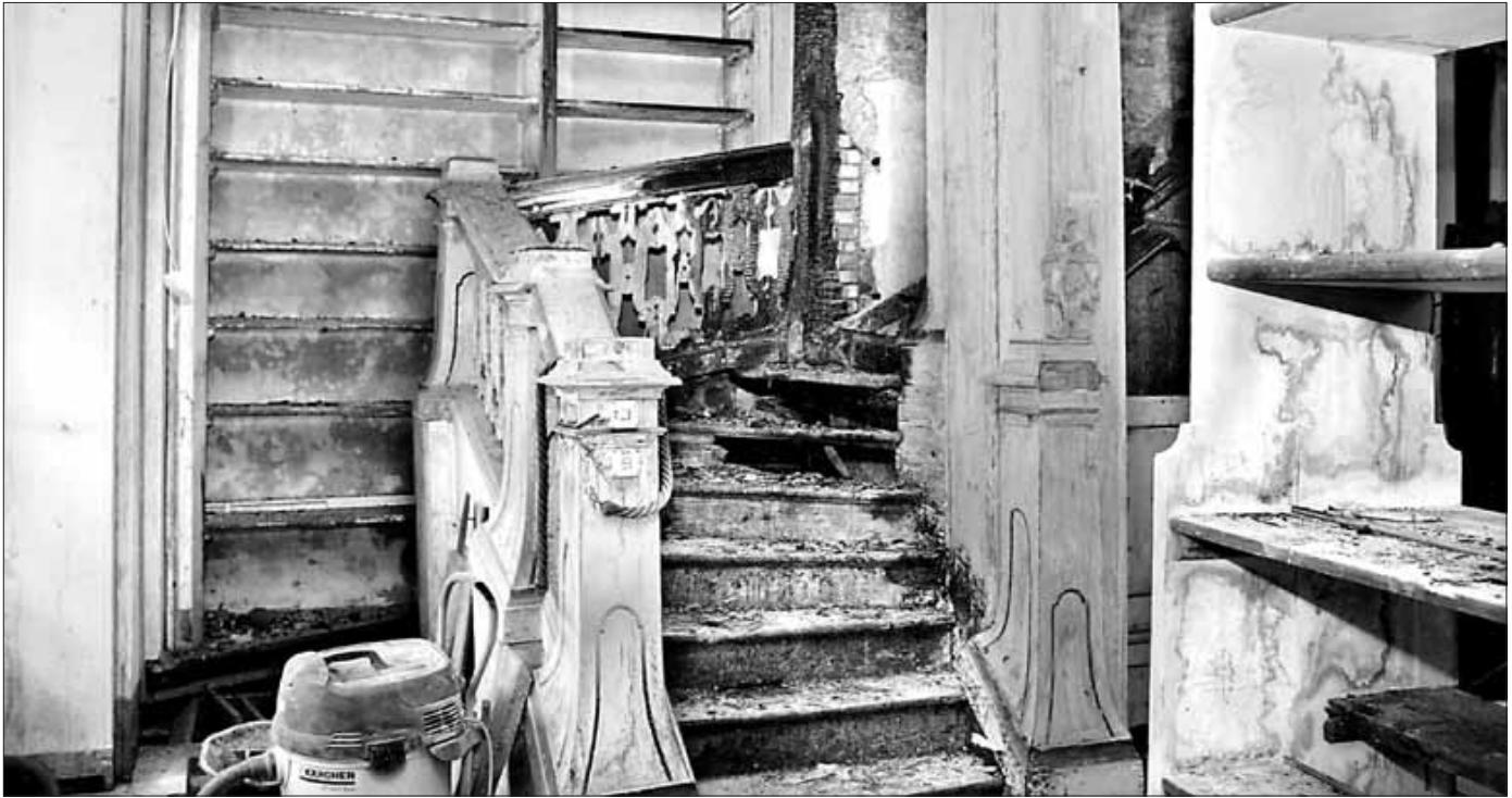
Was nicht verbrannt, wurde durch Löschwasser in Mitleidenschaft gezogen: Der Rokokosaal der Herzogin-Anna-Amalia-Bibliothek. Foto: Jens-Ulrich Koch / ddp
